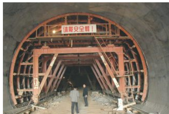
BEDNĚNÍ PRO TUNEL CHEN JIA SHAN
