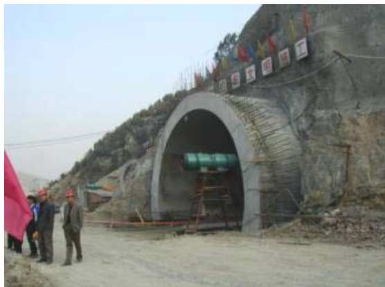
PORTÁL - TUNEL CHANG JIA SHAN
