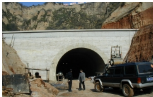
PORTÁL - TUNEL CHEN JIA SHAN
