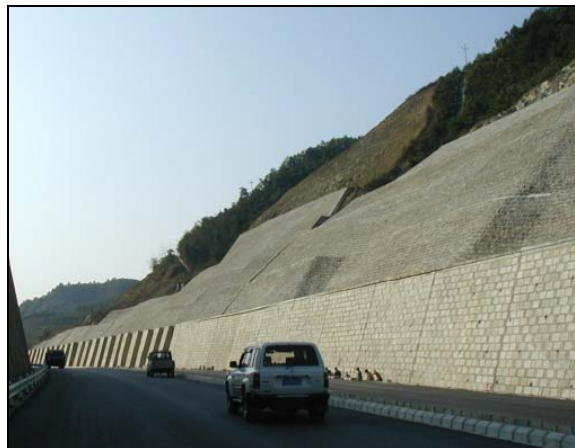
VELKÉ OPĚRNÉ KONSTRUKCE CHRÁNÍCÍ SILNICI
