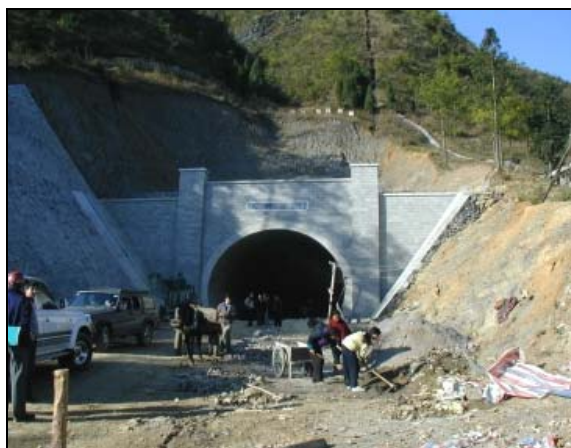
DOKONČENÝ PORTÁL TUNELU
