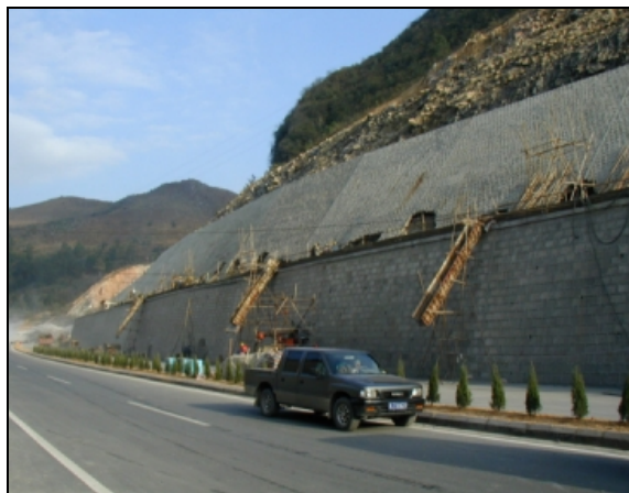
OTEVŘENÁ SILNICE – DOKONČUJÍCÍ PRÁCE
